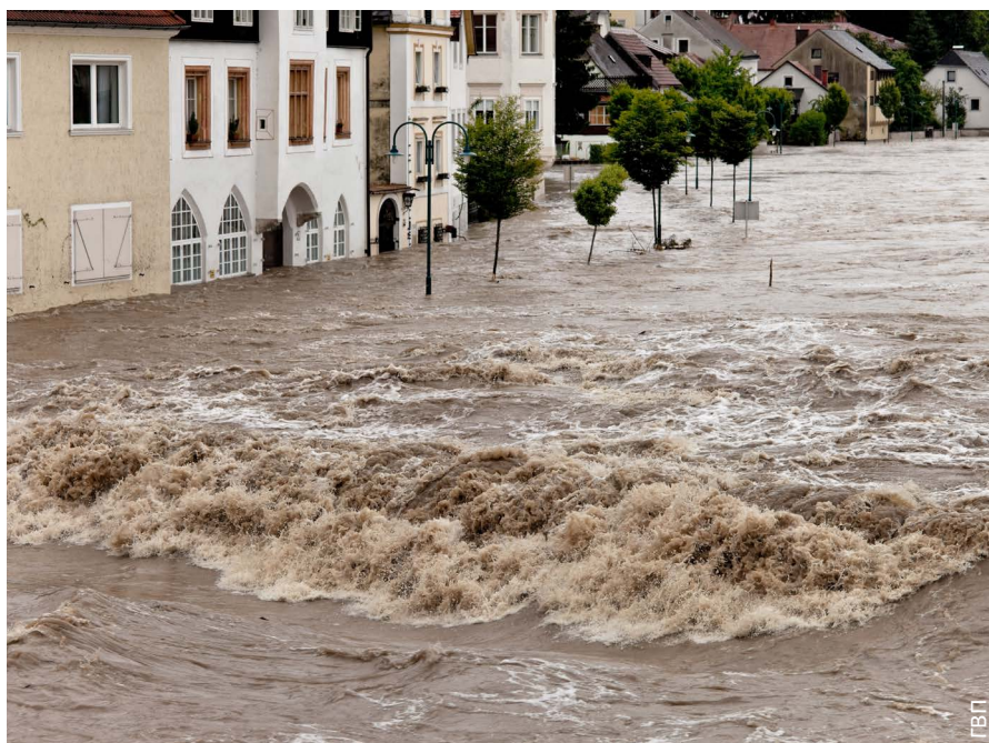
Высокий уровень воды и затопление улиц в г. Штайр, Австрия, служат примером ущерба от наводнений для городского имущества, который оценивается в 120 млрд долларов США в год.
